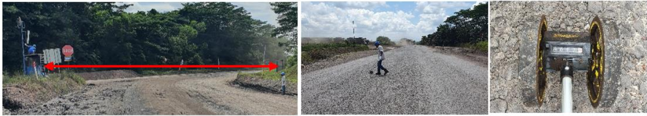
Gambar 6 Pengukuran lebar jalan hauling
